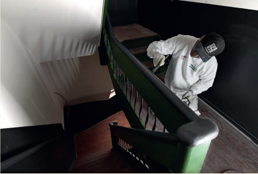
▲ De kleuren van het schilderwerk in Het Schip, afgeleid uit een uitgebreid kleurhistorisch onderzoek, worden zoals architect De Klerk het ooit heeft bedoeld.
