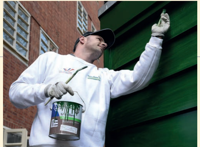
▲ Bij de buitenafwerking van het hout is gekozen voor een zijdeglans lakverf, geschikt voor 4-seizoenen onderhoud.
