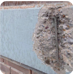
Betoncarbonatatie
