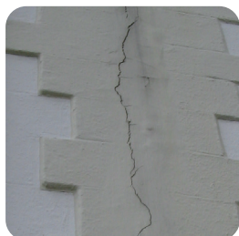
Bouwdynamische scheur
