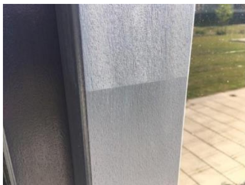
Glansverschil bij laminering van het hout
